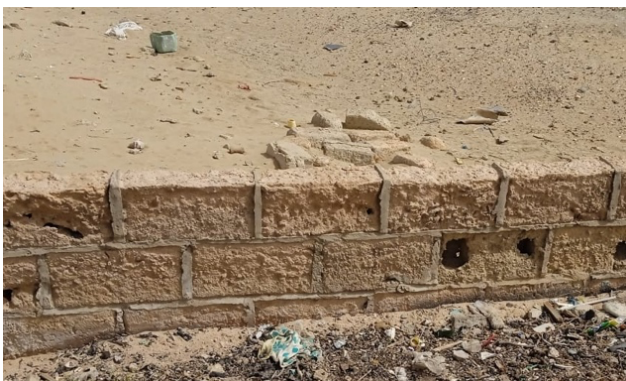
Figure 1: Effets du sel sur les clôtures en briques, Bountou Ndour (St-Louis, Sénégal)
